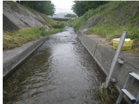
写真1 水位計の取り付け
