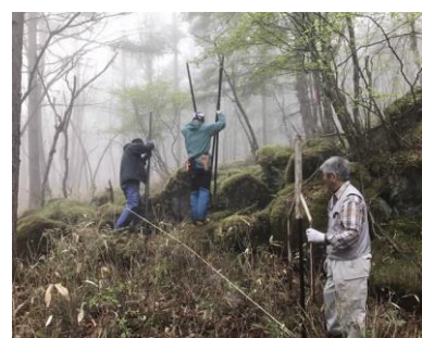
【6/9 保護棚設置作業】
