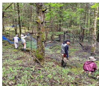
【7/13 保護棚設置作業】
