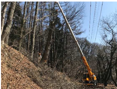
ライフライン沿いの危険木除去作業
