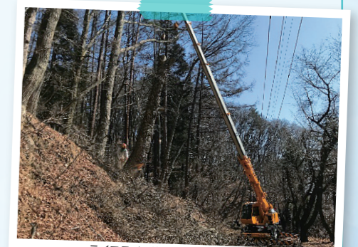
ライフライン沿いの危険木除去作業
