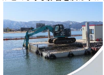
浚渫工事の様子(遊覧船上より)
