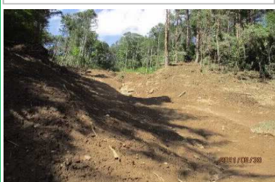
上流域被災状況
