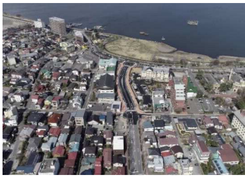
上諏訪駅側から見た柳並線(中央)
