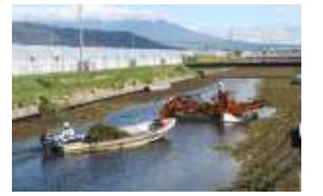
写真-5 刈取作業の様子
