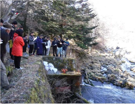
滝之湯堰取水口 滝之湯堰土地改良区役員から説明を受ける
