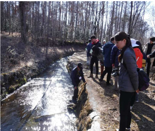
滝之湯堰 石積水路
