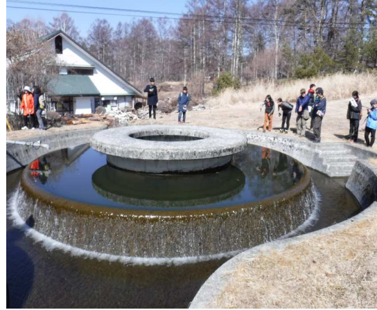
蓼科湖にある円筒分水工(滝之湯堰土地改良区管理)
