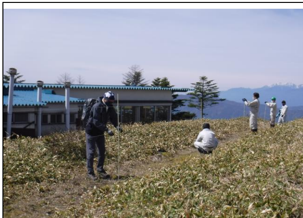
車山肩 設置作業 (5月上旬)
