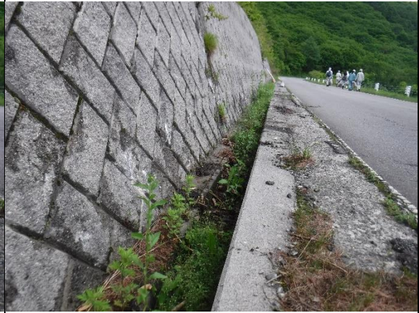
フランスギク駆除作業（作業後）
