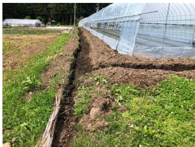
写真31 ほ場① 明渠の様子
