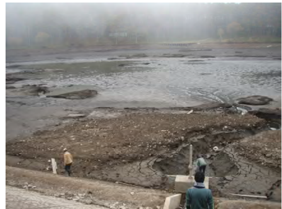
図 水抜き中の大座法師池
