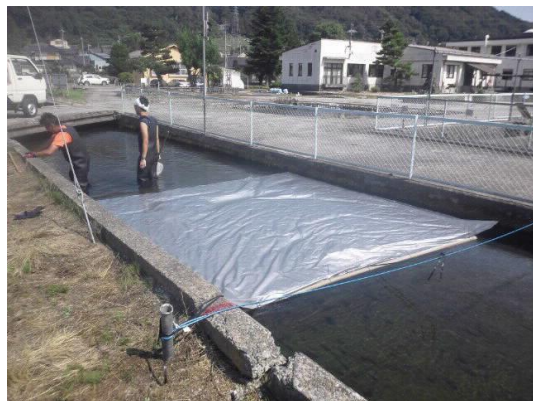
写真 シート設置状況
