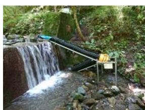
図2 設置した簡易魚道
