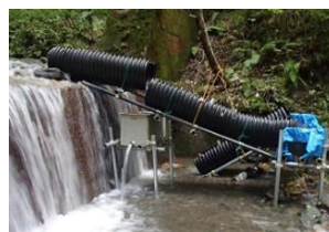
写真2 設置した簡易魚道
