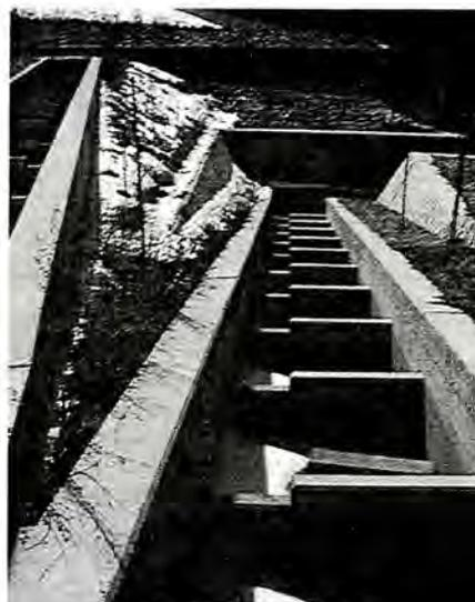
図5 2000年3月の石堂川砂防ダム魚道。水が流れていない。
