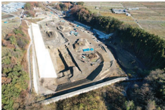
(一級河川黒沢川 安曇野市 黒沢(調節池))
