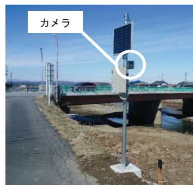
(一級河川滑津川 佐久市滑津橋)
