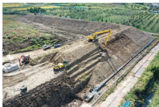
<ため池の防災工事>
