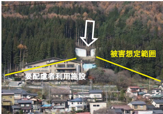
(砂防指定地川鳥沢 塩尻市南原) ※要配慮者利用施設を保全する砂防堰堤
