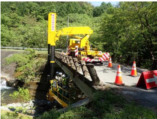
<橋梁点検車による近接目視点>
