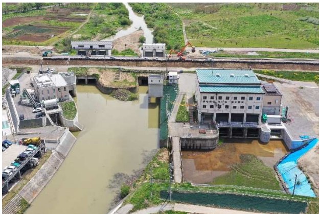
<浅川排水機場>
