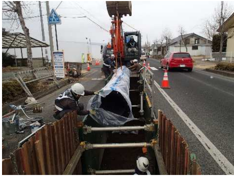
<管路の耐震化工事>
