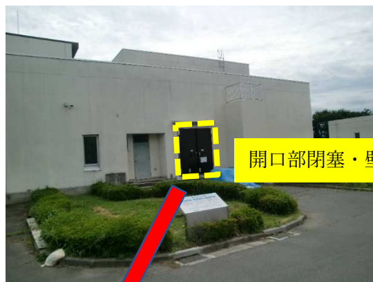
(放流ポンプ棟耐水化)
