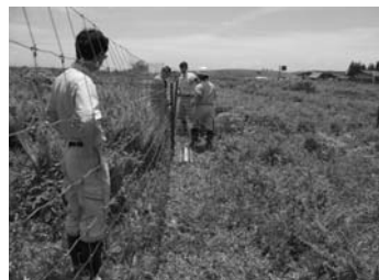
シカ防護柵の設置作業
