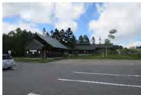
▲南側駐車場から見た自然保護センター(右奥)
