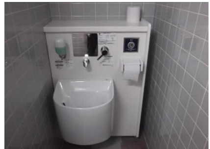
1階検査用トイレ（男）内
