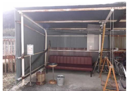
建物西側駐輪場
