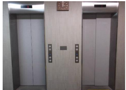
1階EVホール
