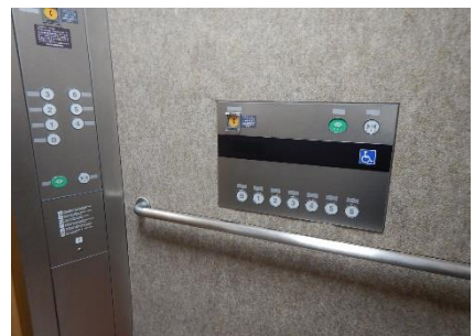
エレベーター内
