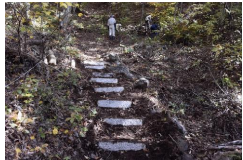
【 遊歩道作業中 】
