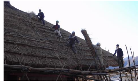
【茅葺作業の様子】
