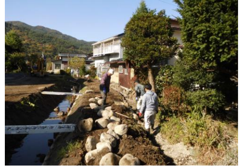
【住民参加の雨水排水路工事の様子】
