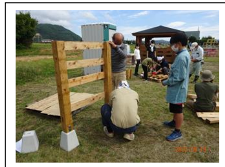
【テーブル、椅子等の組立て作業】
