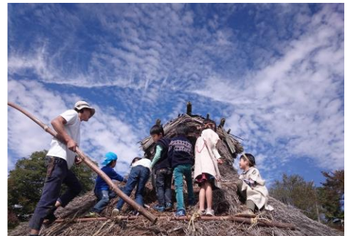
【屋根の葺き替え作業のワークショップ】
