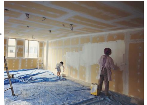
【改修作業の様子】
