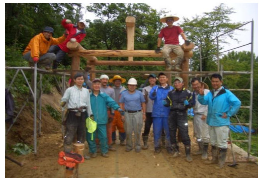
【 東屋の屋根組の組立 】
