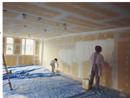
【改修作業の様子】
