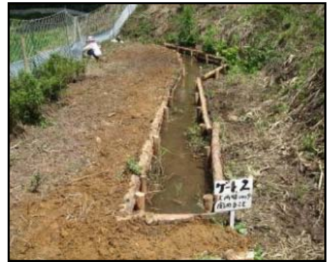
【間伐材を利用した水路整備】
