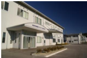
クラスター拠点整備工場
