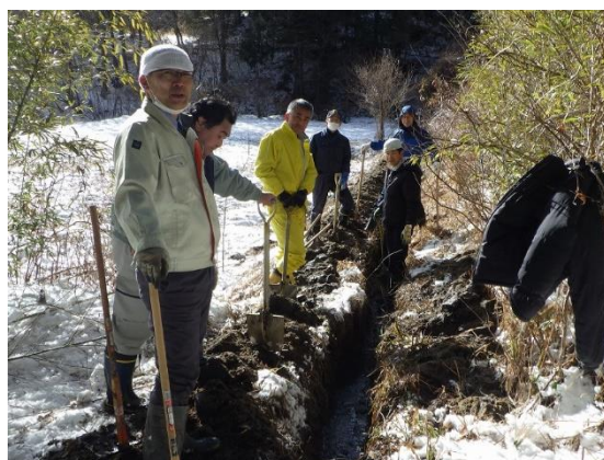
【阿南町】企業参入支援：水路に堆積した土砂の撤去による排水対策を実施（1月25日）
