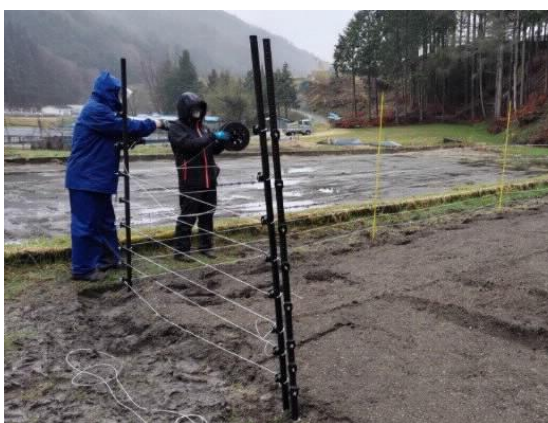
【平谷村】鳥獣害対策として長野式電気柵を設置（4月18日）
