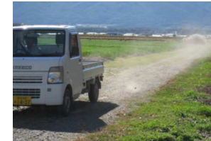
路面が未舗装のため農作物に粉塵被害が生じている
