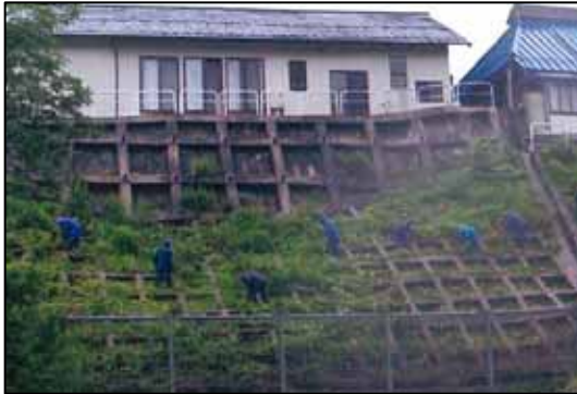
急傾斜地崩壊対策事業 高山村 牧北 (住民参加による草刈りの実施など適切な維持管理を実施)
