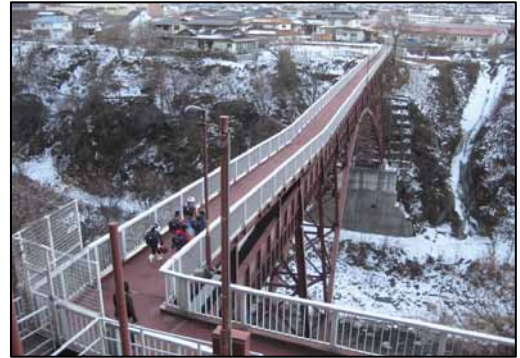
県営かんがい排水事業 伊那市 三峰川右岸 (水路橋上部の管理道路を生活道路(通学路)として有効活用)
