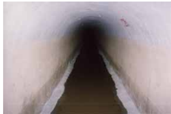
2号幹線隧道補修工事
