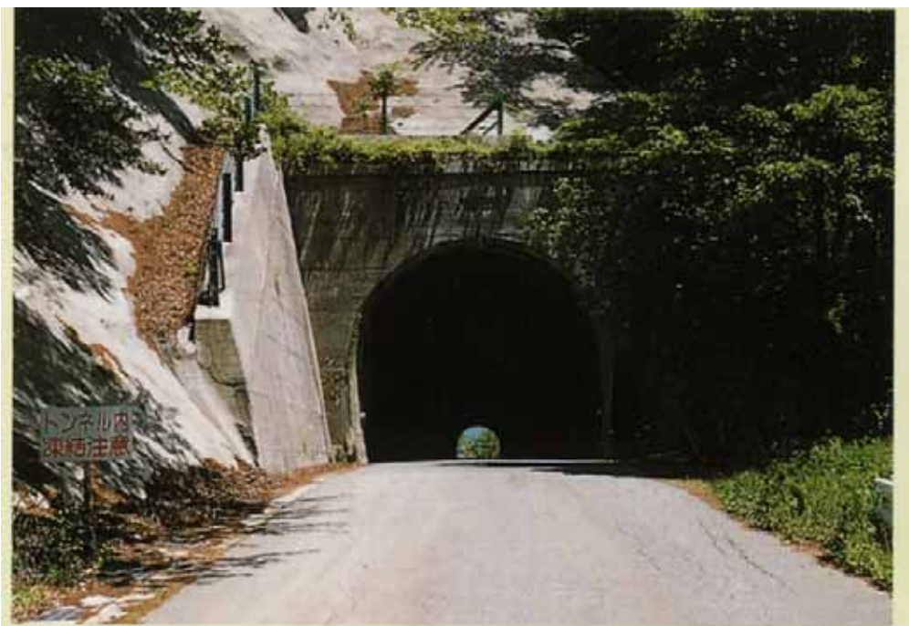
四十八曲トンネル (延長165m、昭和38年建設)
