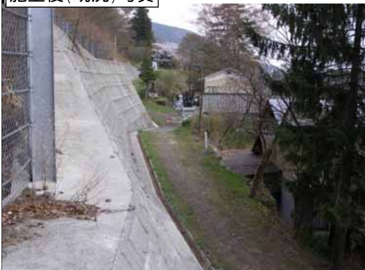
施工後(現況)写真
