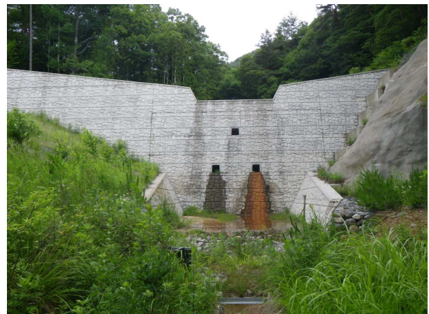
コンクリート堰堤 H=10.5m L=55.0m
