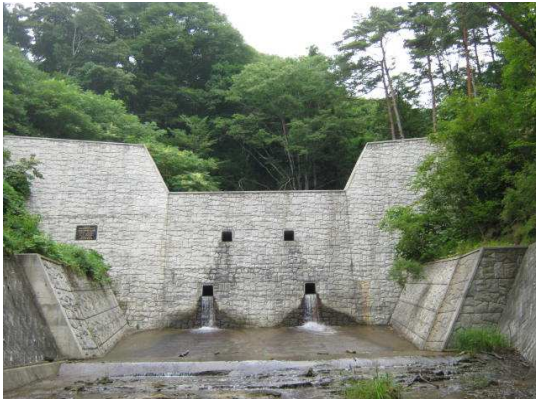
コンクリート堰堤 H=10.0m L=44.0m
