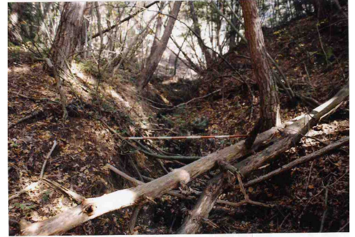
上流荒廃状況
