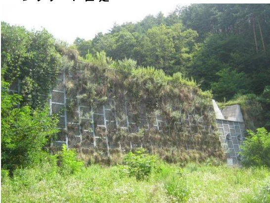
ダブルウォール堰堤 H=12.0m L=91.2m
