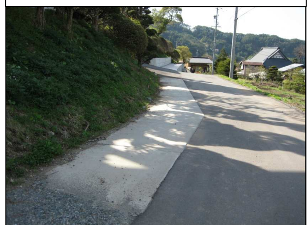
BOXカルバート水路(高1.1m×幅1.4m)の完成
