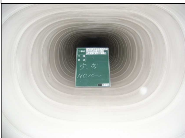
BOXカルバート更生(高1.1m×幅1.4m)の完成
