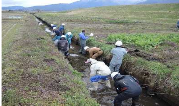
地域資源の基礎的な保全活動（水路の泥上げ）
