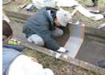
用水路の目地補修
