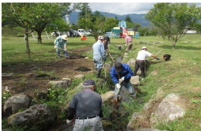
水路の泥上げ
