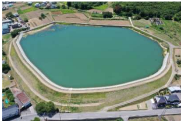
工事施工後(来光寺池:上田市)
