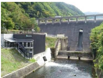
水力発電所 (横川蛇石発電所)
