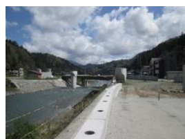
施工状況(2020年5月現在)
