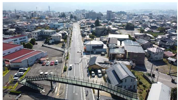
2022年度に完了した箇所 (飯田中津川線 飯田市 知久町)
