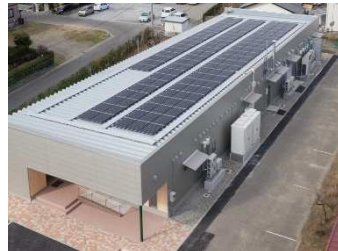
屋根太陽光パネル (工業技術総合センター)
