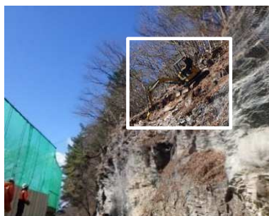
ICT建機による無人化施工
