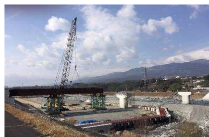
(主)伊那生田飯田線 松川町 宮ヶ瀬橋 (施工中 2019.1)
