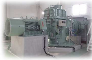
排水機場ポンプ設備更新(須坂市相之島)
