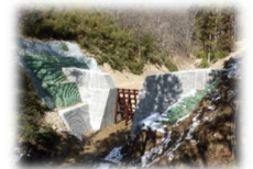
砂防堰堤 (坂城町成久保)
