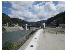
施工状況(2020年5月現在)
