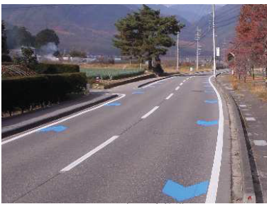
サイクルツーリズム環境整備 矢羽型路面標示
