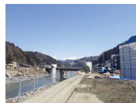
施工状況（2019年3月現在）
