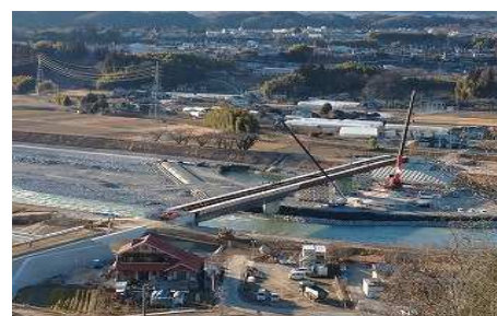
(主)伊那生田飯田線 松川町 宮ヶ瀬橋
