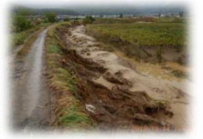
蛭川堤防復旧（長野市東寺尾）
