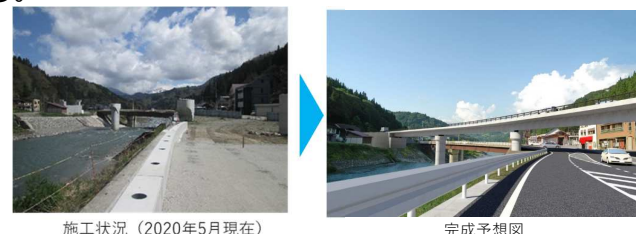
施工状況(2020年5月現在)
