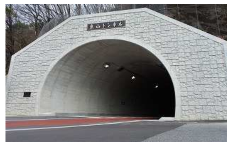
(主)松川インター大鹿線(渡場～滝沢) 東山トンネル
