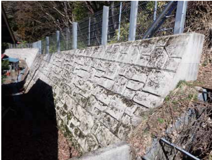
化粧型枠状況
