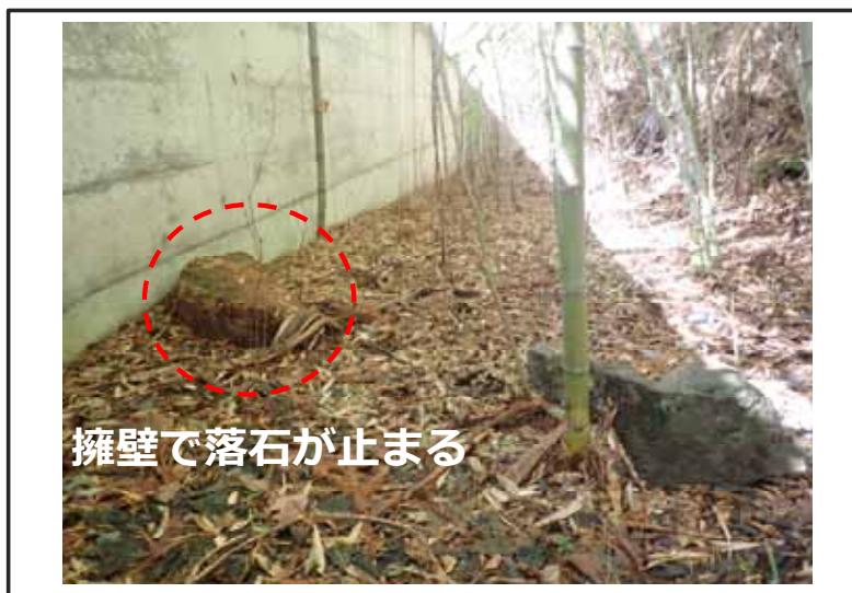
落石捕捉状況
