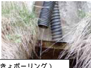
地下水排除工 (暗きょボーリング)
