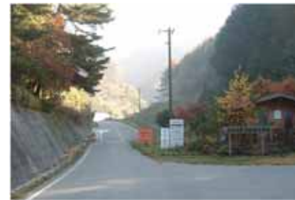
林道の通行止め状況
