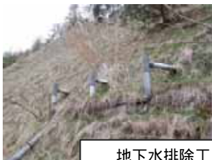
地下水排除工 (暗きょボーリング)
