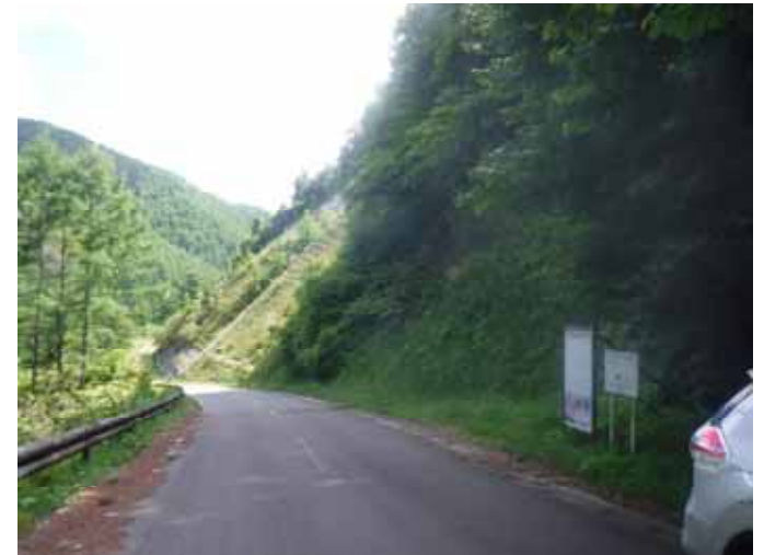
定期的な施設点検（法面）
