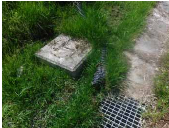
定期的な施設点検（排水施設）
