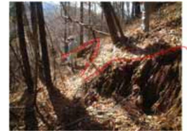
上部に発生した亀裂
