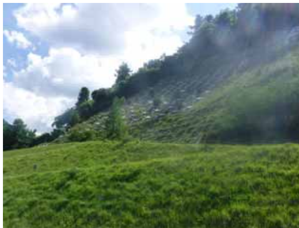
法面の緑化状況
