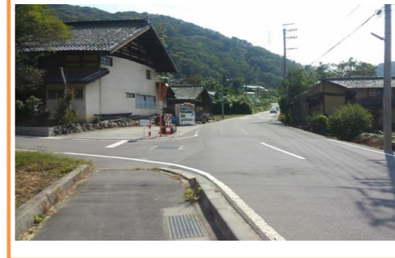
現道状況 (線形不良、幅員狭小)
