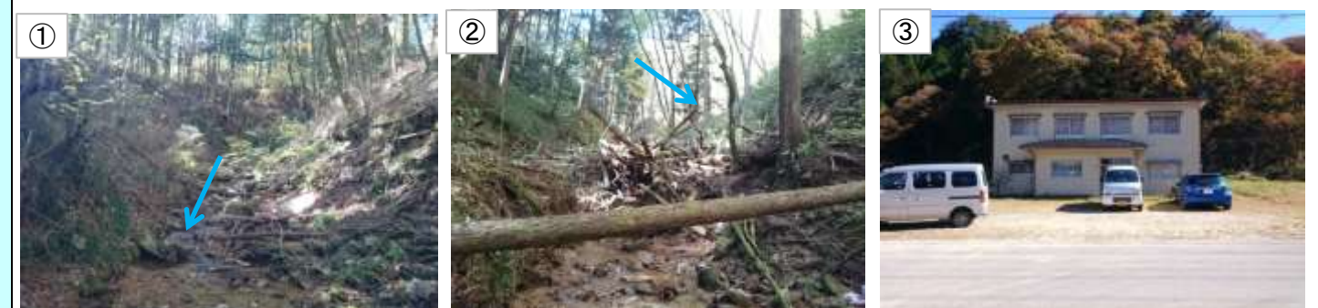
① 砂防堰堤設置予定箇所 ② 倒木が多数堆積している ③ 新町集会所(指定避難所)
