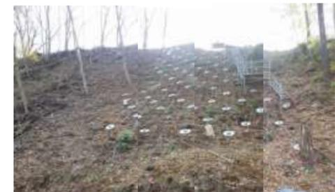
補強土工法により斜面表土化塊の安定を図り、山腹斜面崩壊拡大防止により森林化の基礎とする。(写真はイメージ)
