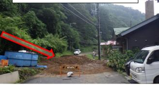
旧耕作地内の荒廃状況 ○流路工を計画し、乱流している渓流の流路 の規制と渓岸浸食の拡大防止を図る。
