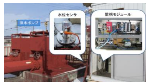
● 内水排水ポンプ監視システムのイメージ
