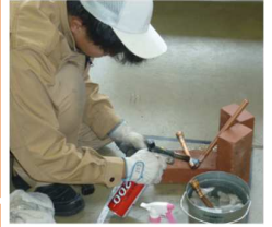
配管を溶接する様子 （松本技術専門校：冷凍空調設備科）
